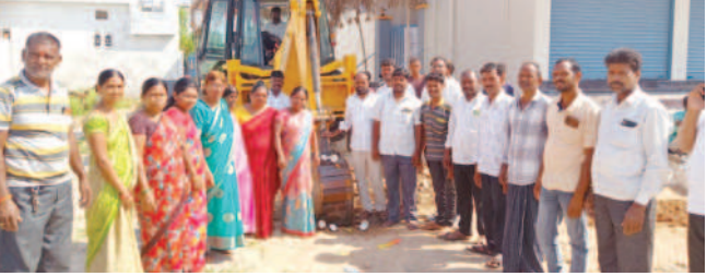
పైప్‌లైన్ నిర్మాణ పనులను ప్రారంభిస్తున్న దృశ్యం
