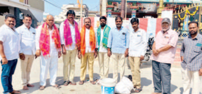
నాగారం మున్సిపాలిటీలో 19 వార్డులో ఆండర్‌గ్రౌండ్ డ్రైనేజీ,సీసీ రోడ్డు వసులకు శంకుస్థాపన చేస్తున్న మున్సిపల్ చైర్మన్ కోకట్ల చంద్రారెడ్డి
